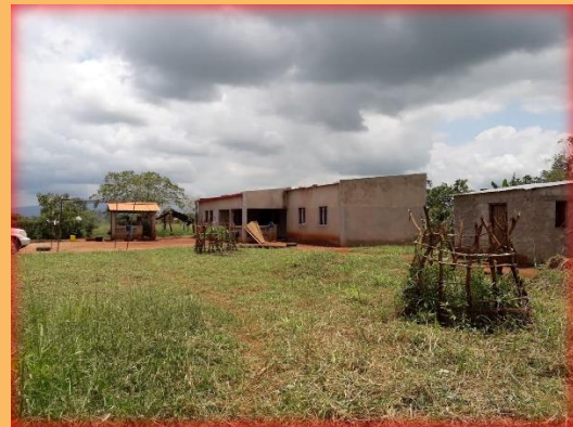
PROYECTO EN CONSTRUCCION
